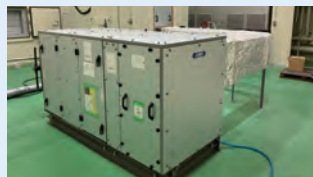
综合实验楼的空气处理机组的制冷能力试验
