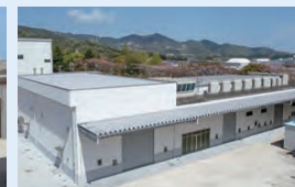
综合实验楼 SINKO AIR DEVELOPMENT LAB
