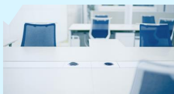
パーソナル空調 デスク上に個別の吹き出し口を設け 自分好みの空気環境を構築
